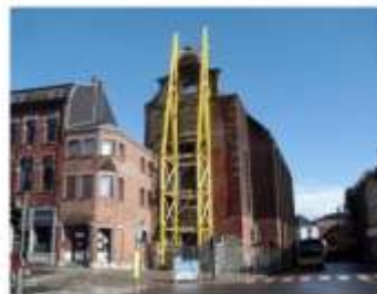
La stabilité du bâtiment restauré garantie à ce stade. © Dapress
