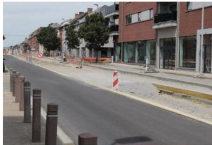
Le chantier continuera ensuite du côté pair de la voirie. © David Claes
