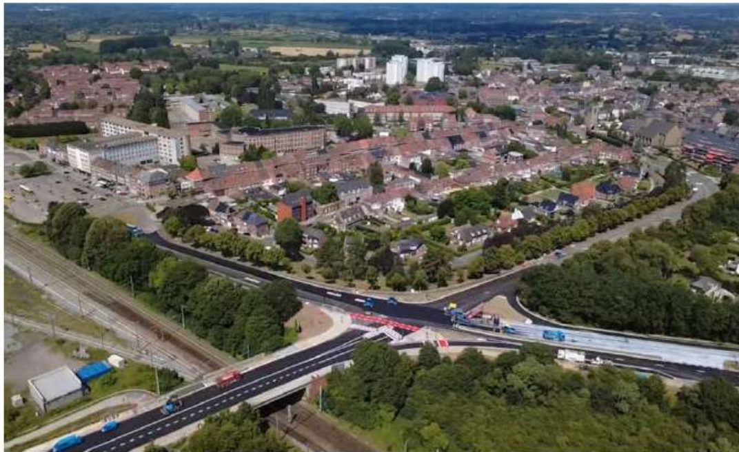
■ Le viaduc de Saint-Ghislain poursuit sa transformation. © D.R.
