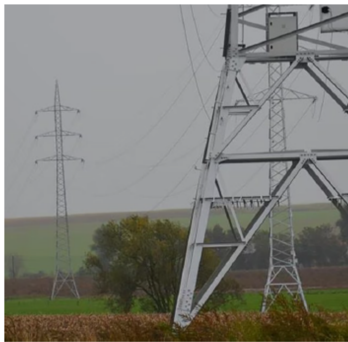
Le collège communal du Roeulx ne veut pas de la ligne haute tension. © EDA
