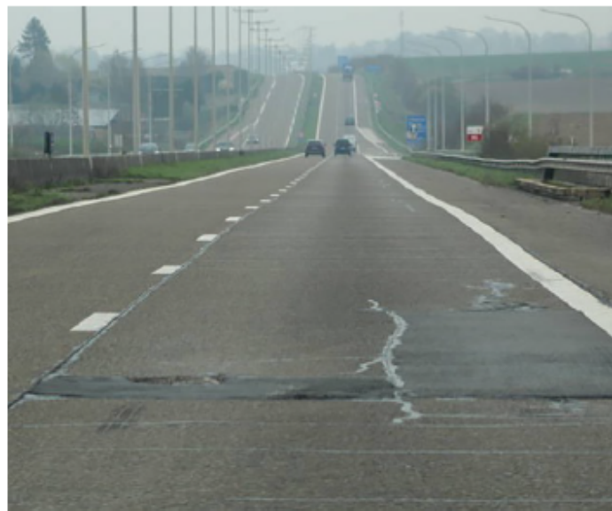
■ Le R5 va être réhabilité entre Jemappes et Asquillies. Le chantier débutera au printemps. © SH
