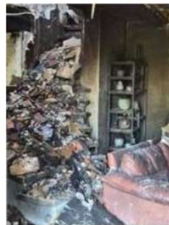
Des dégâts importants... © D.R.
