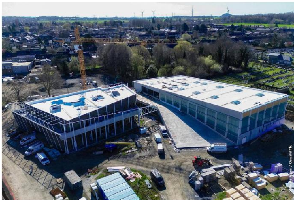
■ La nouvelle crèche de Cuesmes s'intègre dans un pôle récréatif qui comprendra un hall sportif, une salle Calva et un parc de loisirs. © D.R.
