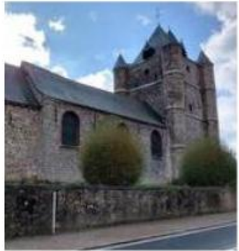
À Saint-Vaast, la tour servait à l'origine de donjon. © David Claes
