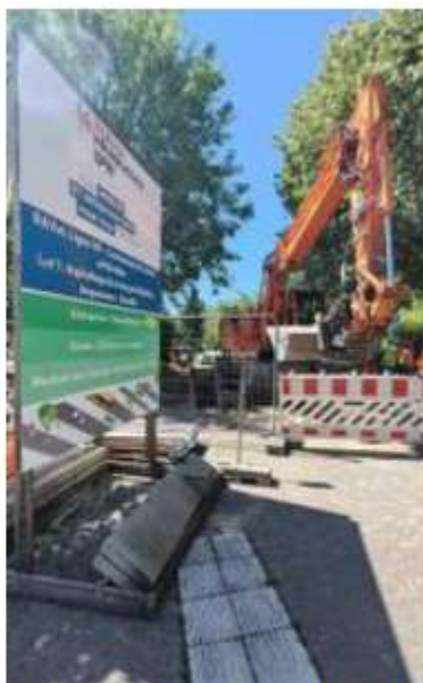
Travaux aux abords de la ligne 141 du RAVel © D.R.
