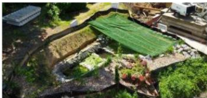
Les aménagements des bassins et le gros œuvre avance. © Ville de Binche
