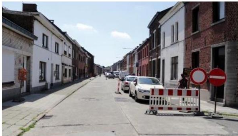
Le chantier a débuté. © DC
