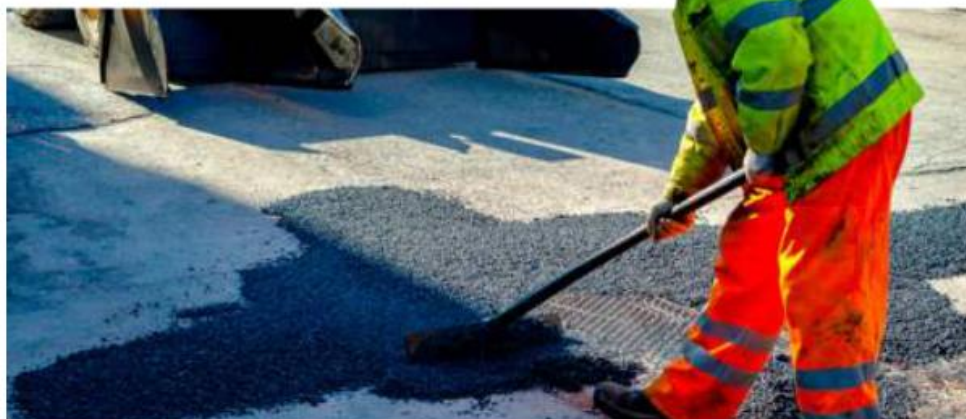
Le volume de travaux réalisables est aujourd'hui presque réduit de moitié. © iStock
