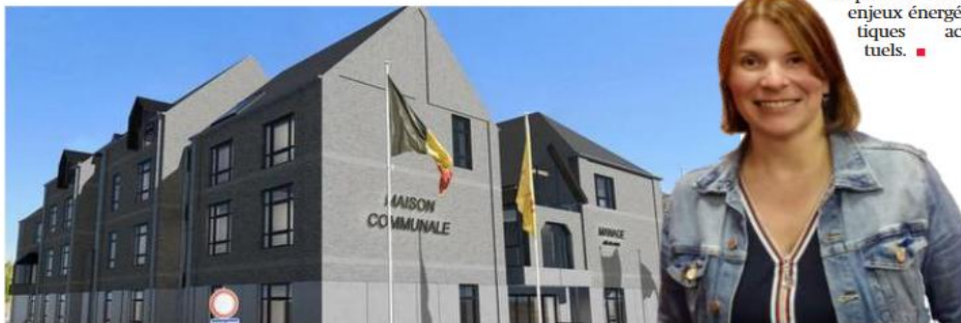
Le vaste chantier de rénovation énergétique de la maison communale de Manage touche à sa fin. © DR
