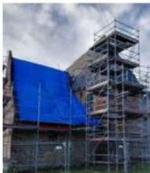
Un chantier à l'arrêt depuis des mois ! © DC
