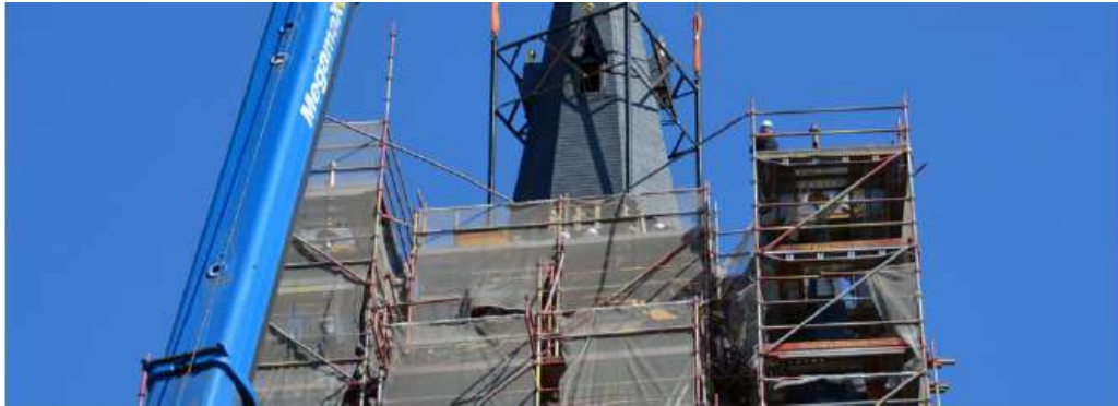
■ L'église Saint-Martin a retrouvé sa flèche lors d'une installation rondement menée. © EDA
