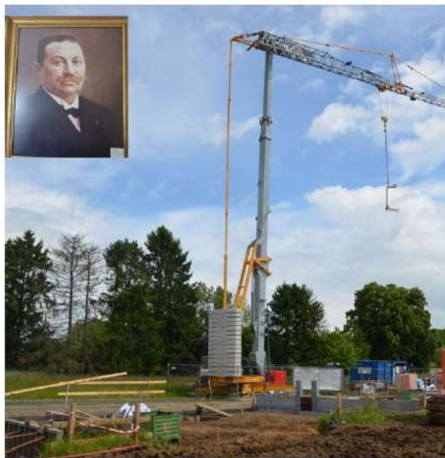
■ Les travaux ont débuté au sein de la ZACC Belle-Eau. © EDA
