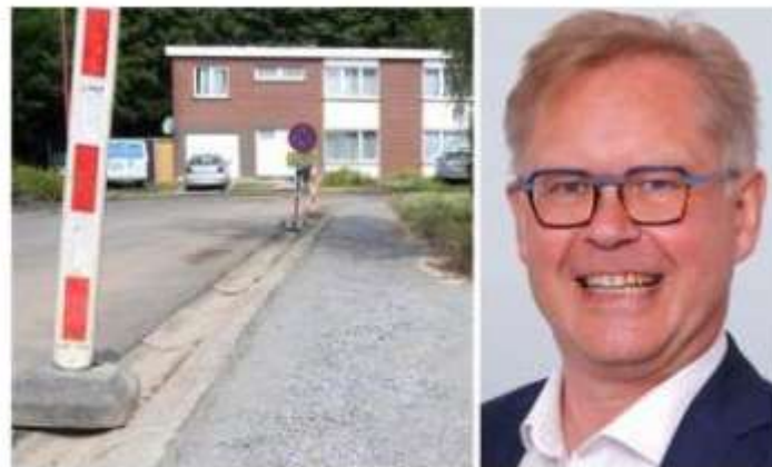
L'échevin évoque des travaux de rénovation de trottoirs. © D.C. et D.R.
