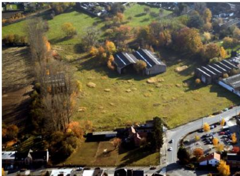
Vue aérienne du site de l'ancienne papeterie Catala, qui deviendra une cité administrative à Braine-le-Comte © SPAQUE
